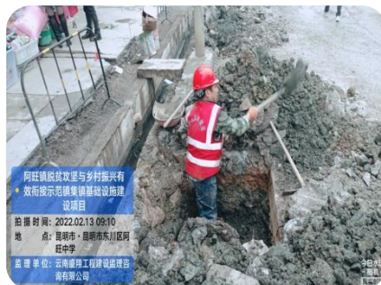
检查井接管施工
