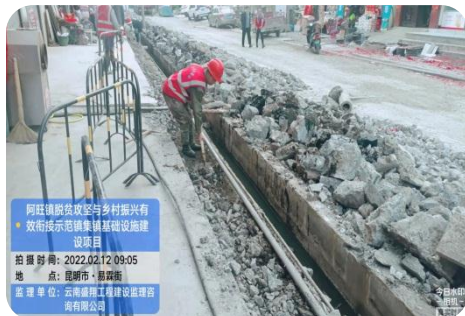
以霖路人行道盖板拆除
