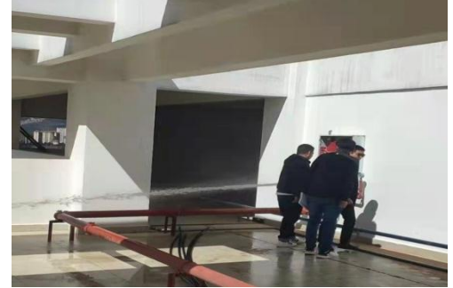
屋顶水压检测
